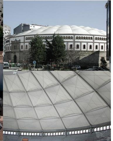
La estructura de la cubierta de la Plaza de Toros de Pontevedra está concebida como una estructura laminar, con forma de casquete esférico truncado de 69,00 m de diámetro y un anillo central abierto de 25,00 m de luz.
